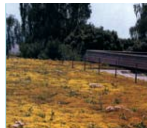
Een extensief groendak vergt wegens de begroeiing - mossen, vetplanten en kruiden - geen speciaal onderhoud, noch een speciale dakconstructie.
